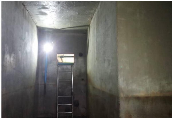
รูปที่ 2.2-21 ทำความสะอาดถังเก็บน้ำใช้
