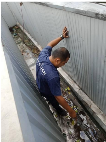
รูปที่ 2.2-21 ทำความสะอาดถังเก็บน้ำใช้
