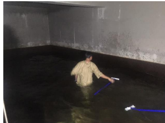
รูปที่ 2.2-21 ทำความสะอาดถังเก็บน้ำใช้
